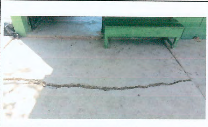
Foto 2: Mejoramiento y sustitución de piso.
