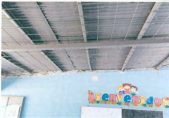
Foto 3: Reparación de repello y cernido de paredes.
