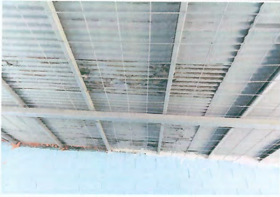
Foto 1: Mejoramiento y sustición de cubierto de lamina.
